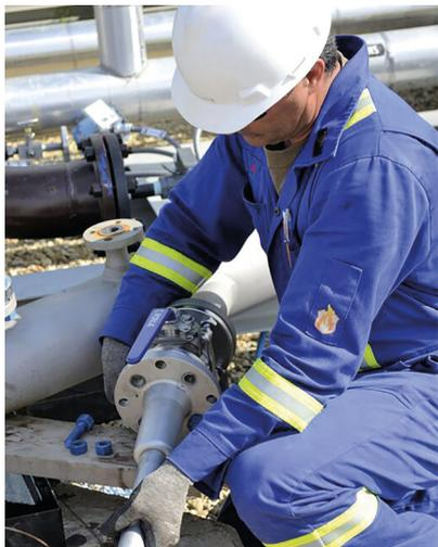
Технология измерения расхода факельного газа является одной из самых сложных в нефтегазовой промышленности. Такие параметры факельных линий, как состав, температура, давление газа и интенсивность газового потока, непрерывно изменяются. Кроме того, в некоторых областях применения на преобразователях могут образовываться загрязняющие отложения парафинов, смол, сажи, жидкостей и песка.
